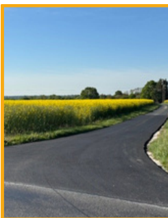
Rue de l'Aérodrome : réfection de voirie au début de la rue
