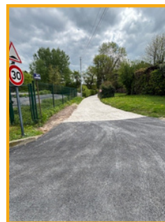
Cour d'Auvergne : réfection de voirie
