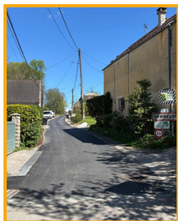
Rue des Berges : réfection de voirie, accotement, pose de bordures et de caniveaux
