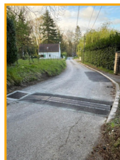
Rue Boularde, rue du Gué Plat et rue de Montmartin : Pose de grilles de caniveau et de bordures afin de canaliser les eaux de ruissellement
