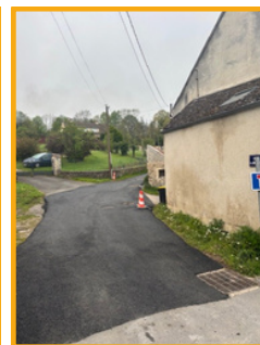
Rue de la Bilbauderie : réfection de la voirie
