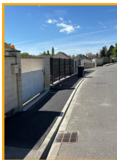
Rue Pasteur : reprofilage du trottoir et pose d'une grille pour canaliser les eaux de pluie
