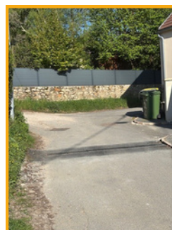
Rue Boularde, rue du Gué Plat et rue de Montmartin : Pose de grilles de caniveau et de bordures afin de canaliser les eaux de ruissellement
