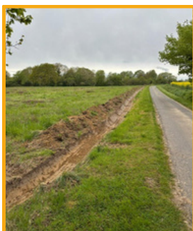
Rue des Bleuets : création de fossés pour les eaux pluviales
