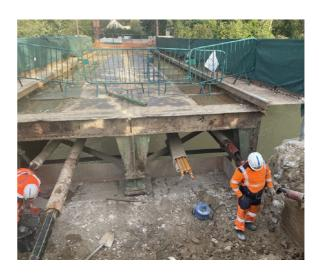
Aujourd'hui le chantier suit son cours, toujours dans les temps car il n'y a aucun de jour de retard à déplorer. Le sablage du pont permettra de révéler l'état de la structure métallique et de savoir quelles parties pourront être conservées. Il s'agira ensuite d'effectuer les réparations et remplacements pour lesquels ces travaux ont été initiés. Une fois, ceux-ci effectués, le pont pourra être remonté.
