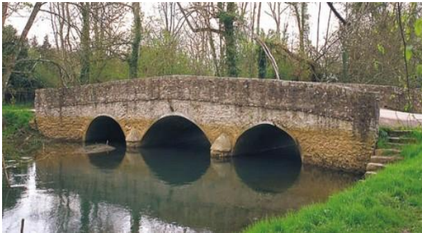
Le pont actuel de POMMEUSE
