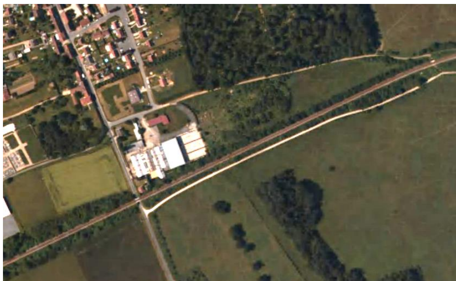
Photo aérienne de 2003 du site d'étude
