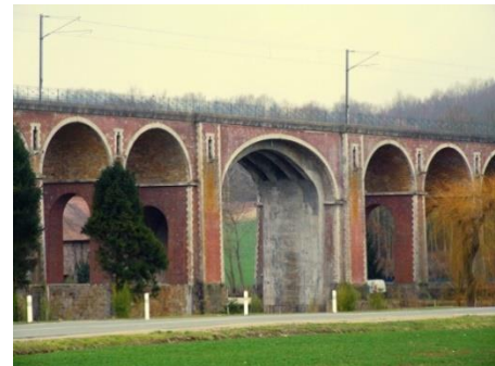
Le viaduc de l'AUBETIN
